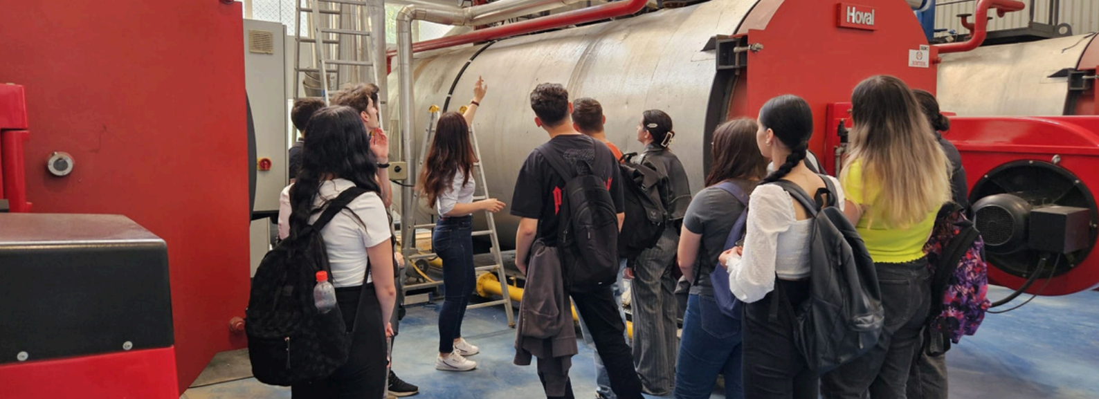
Centrala electrică Laborator CET
