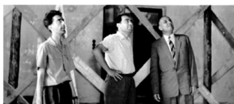
Rectorul Constantin Dinculescu pe șantierul Laboratorului de Tehnica Tensiunilor Înalte (Polizu, 1960)
