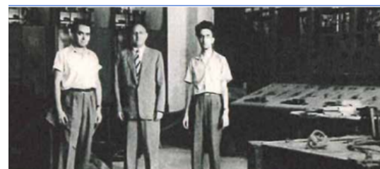
Profesorul Constantin Dinculescu în Laboratorul de Centrale, Stații și Posturi de Transformare (1960)
